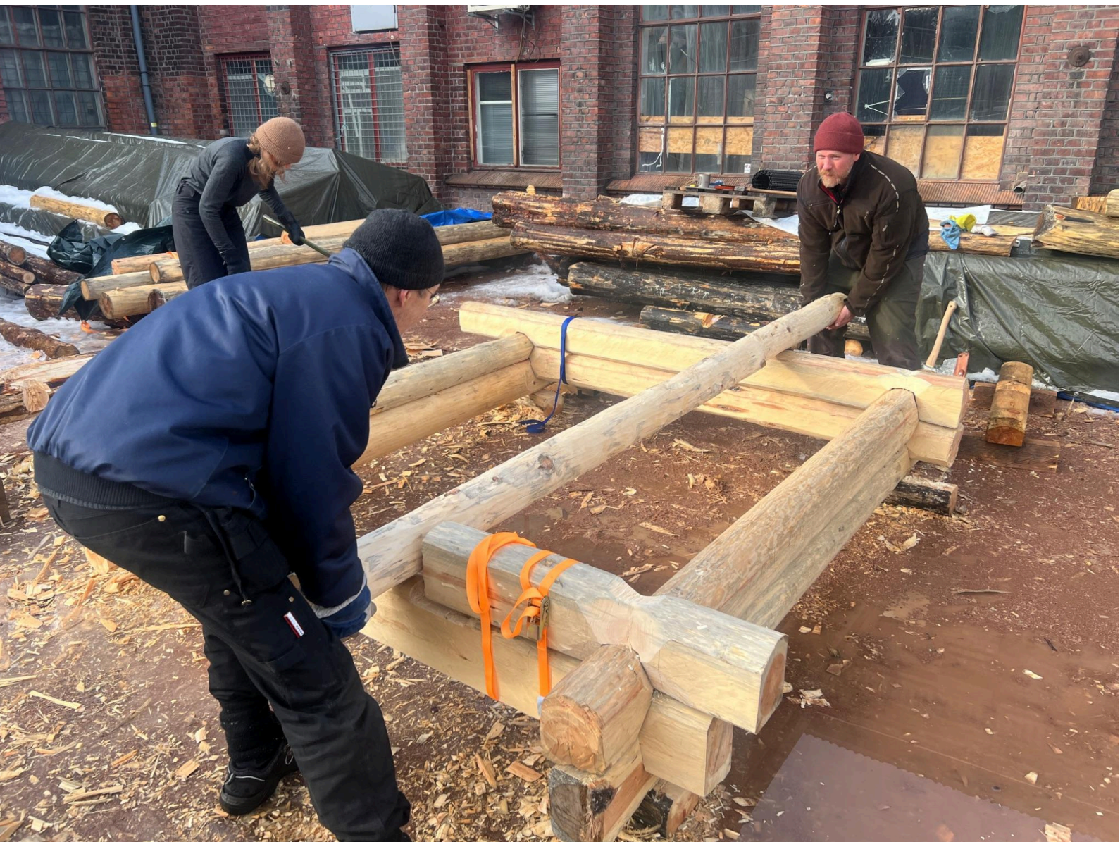
Frivillige lafter sammen med eksperter på byggeplassen i Middelalderparken.
